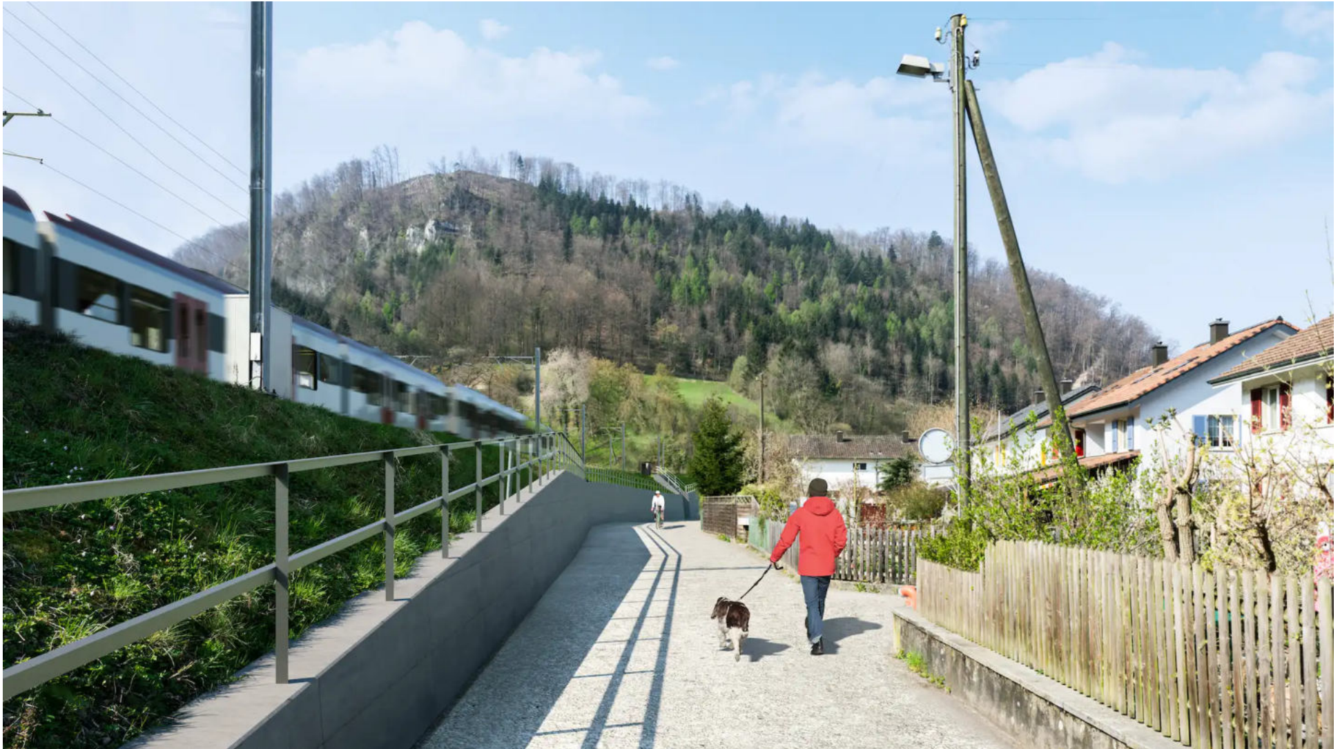
Grellingen: Stützmauer Unterer Moosweg.
