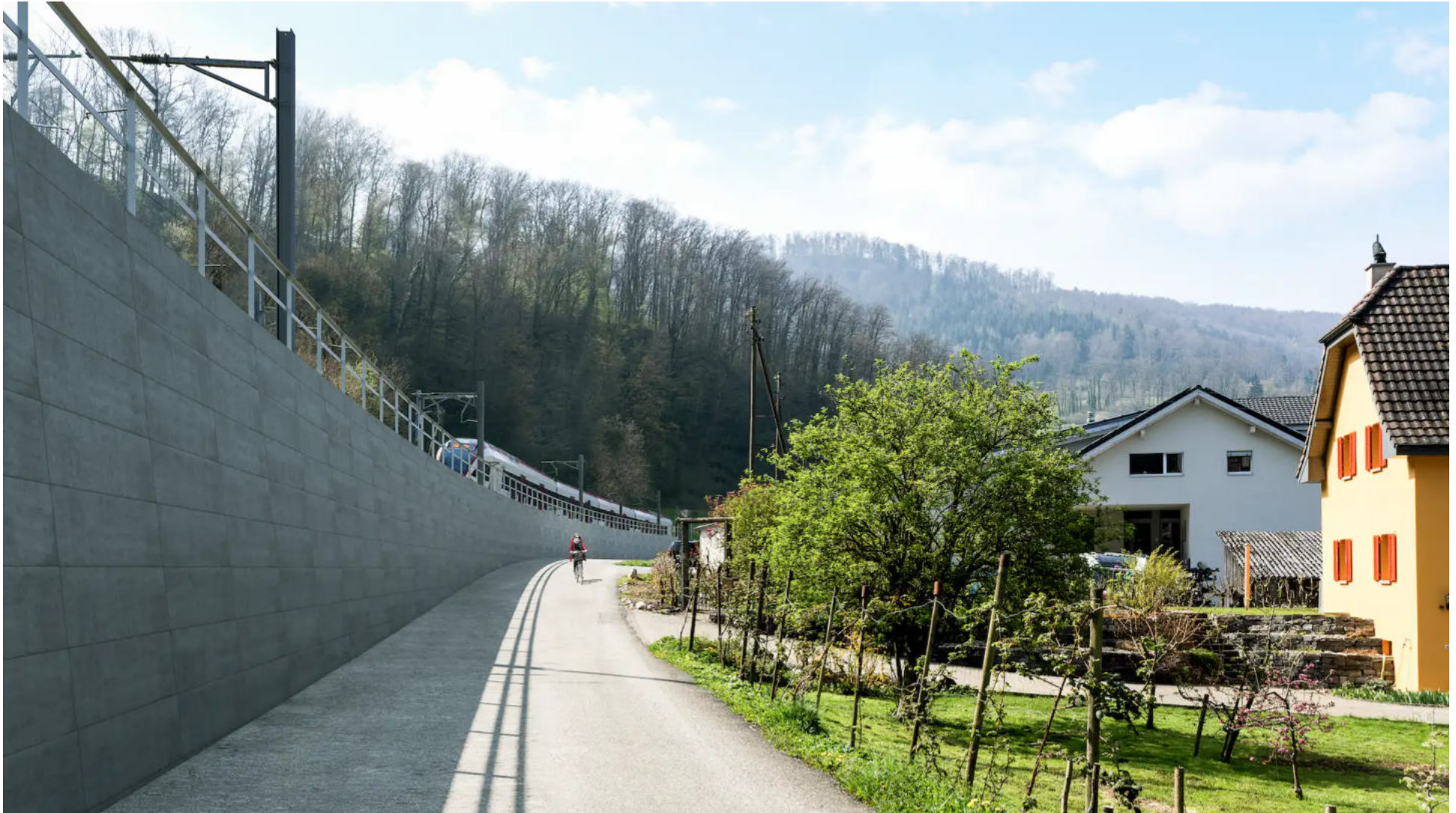
Duggingen: Stützmauer Sennematt.
